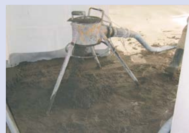
Réaliser une chape de ≥ 6 cm d'épaisseur sur l'insulit Bi+5
